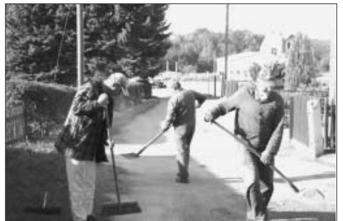
Das Bild zeigt Mitarbeiter des Bauhof bei Arbeiten zur Schlaglochausbesserung in der Wiesenstraße
