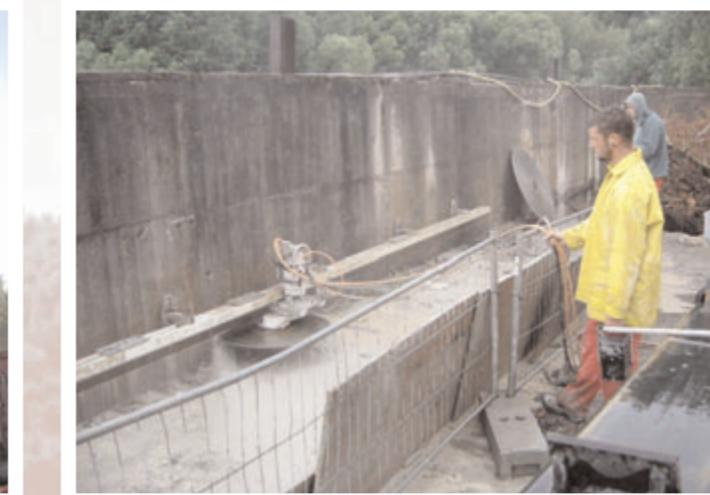
Die Ufermauer am ehem. Kohlelagerplatz wird abgesägt.
