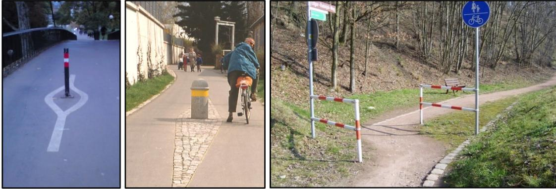
Abb. 29 Beispiele für die Reduzierung von Konfliktpotenzialen an Pollern / Umlaufsperrern
